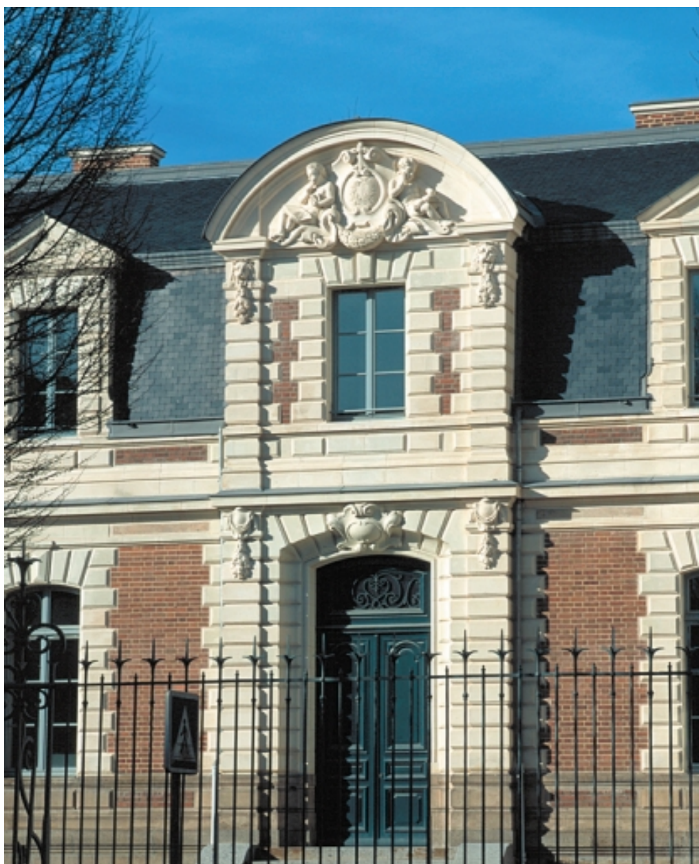
Détail de la façade est
