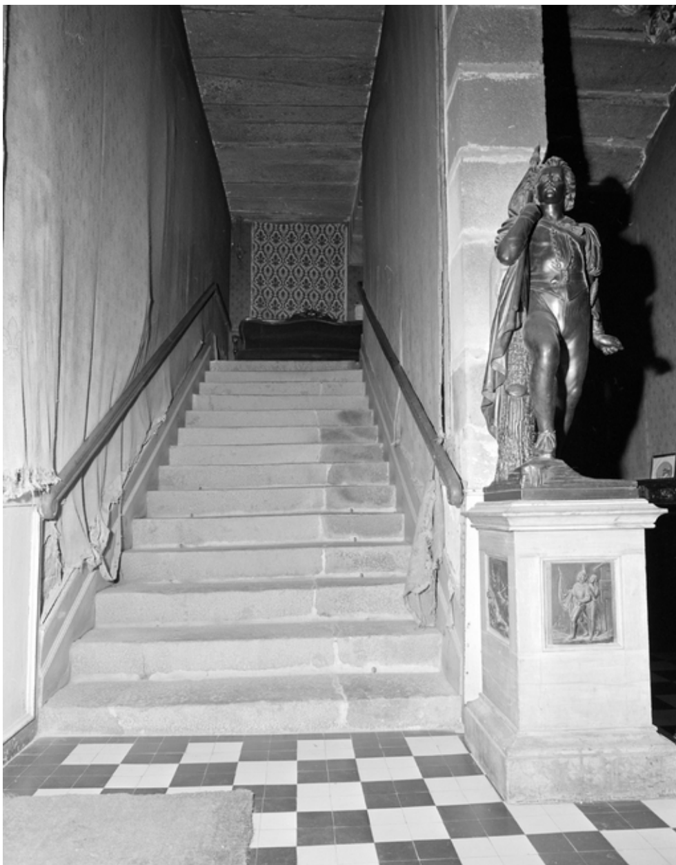
Escalier intérieur, état en 1977
