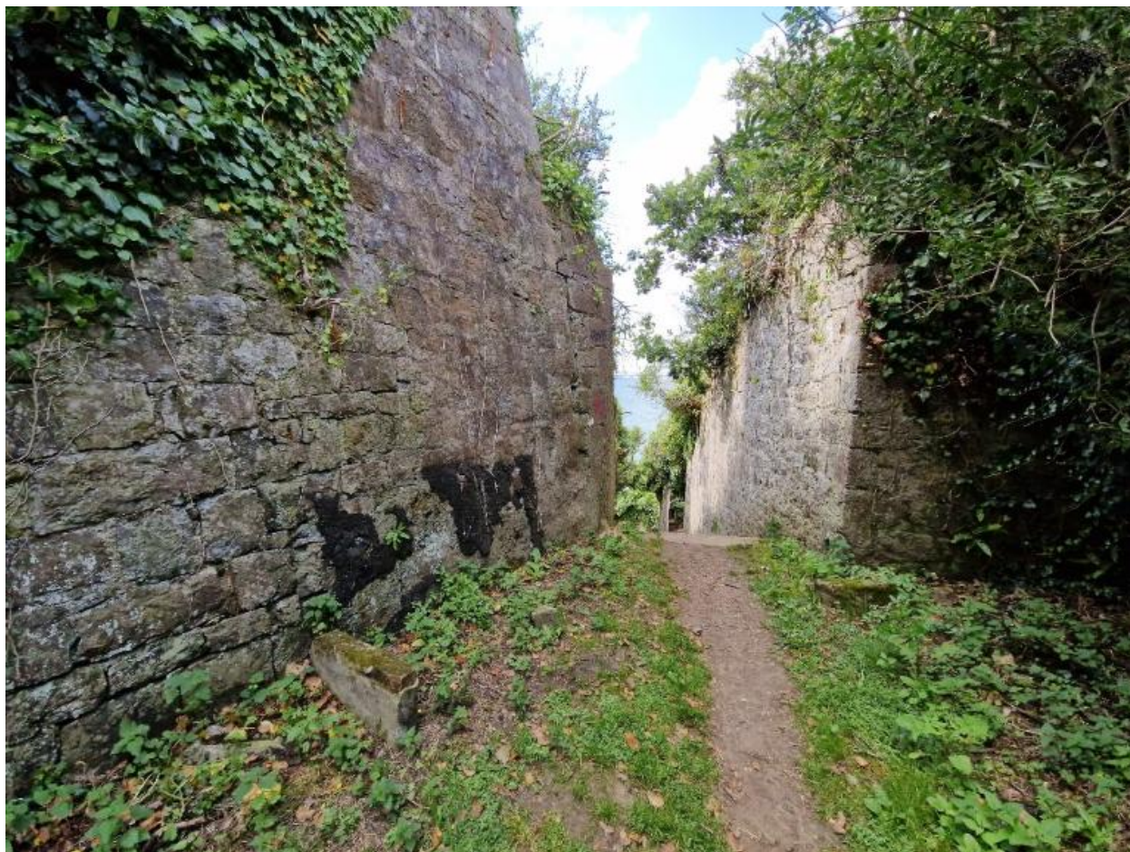
Vue de l'extrémité du fossé sec menant - via un escalier - à la batterie basse (état en 2024)
