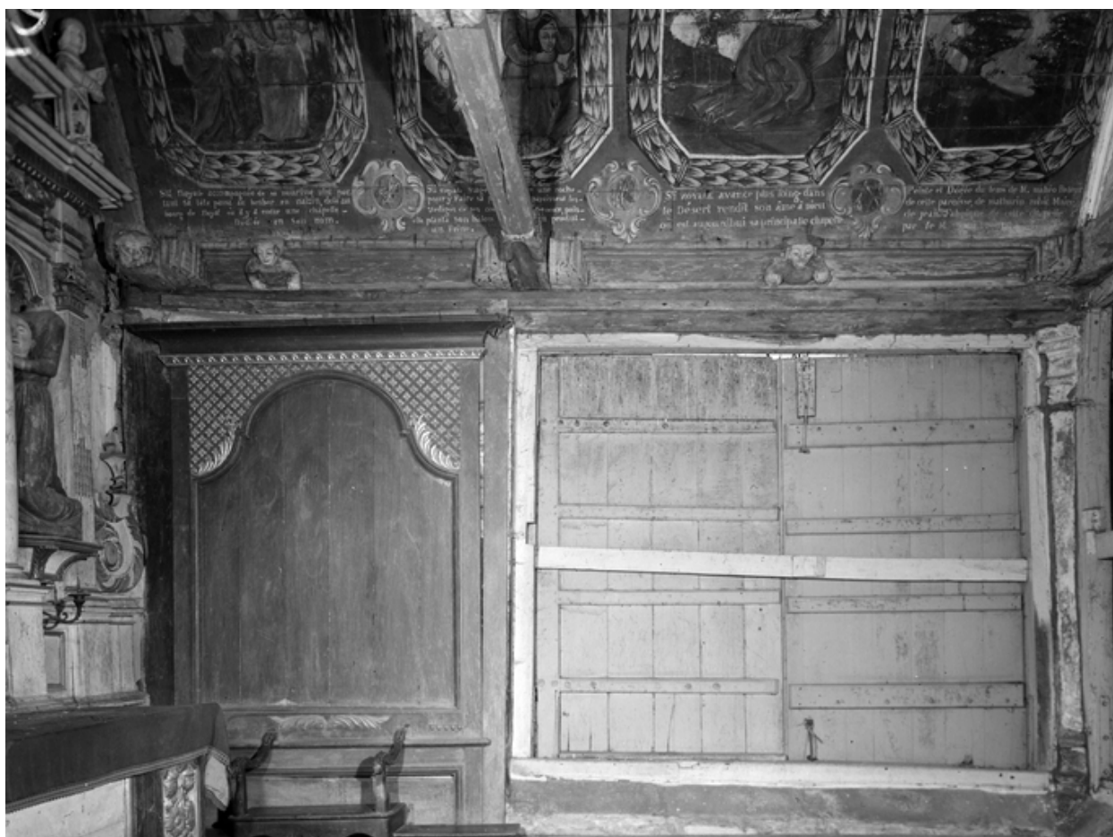
Vue d'ensemble du mur sud, lambris, sablière et voûte peinte.
