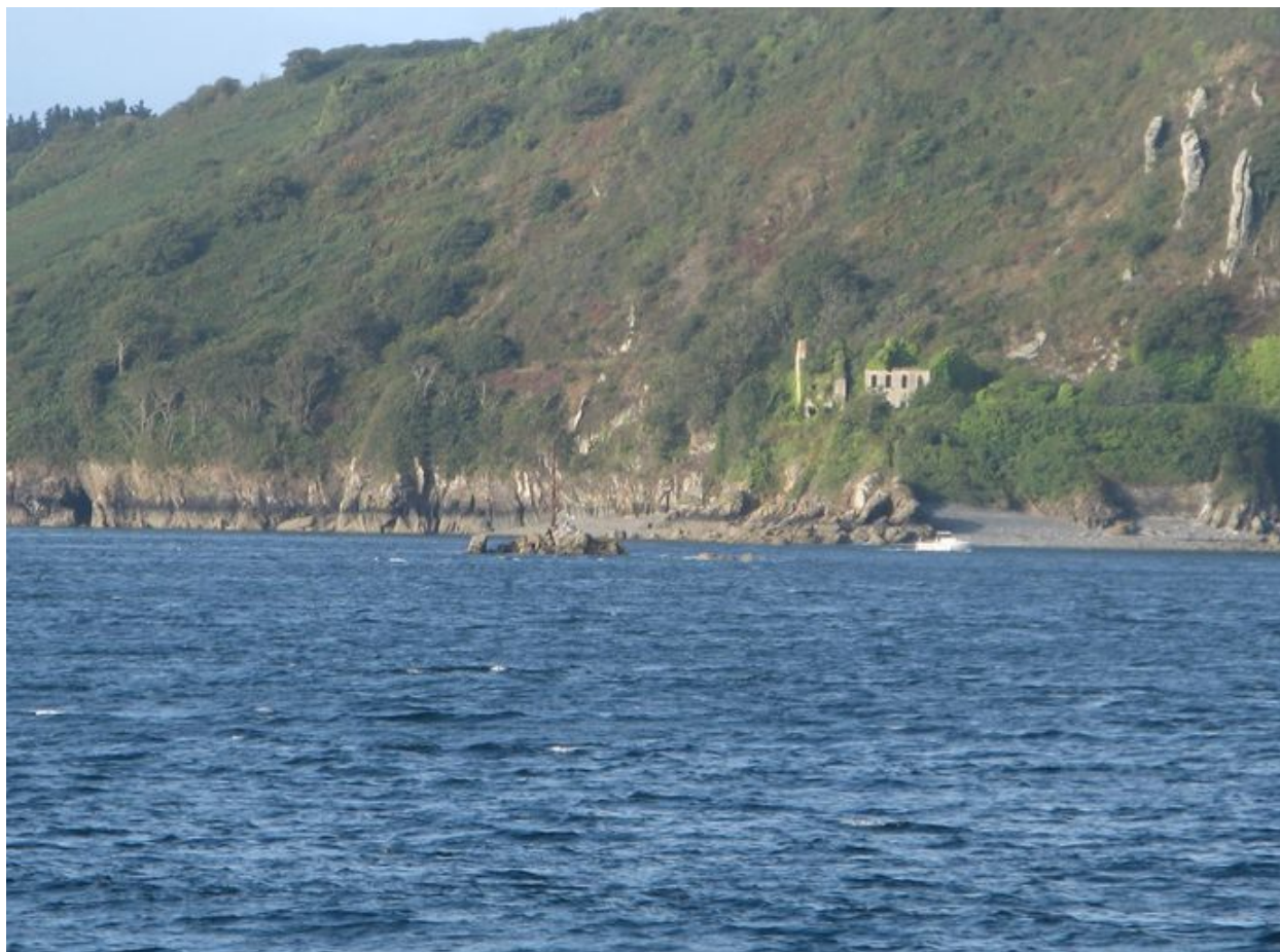
Batterie basse de la pointe des Espagnols
