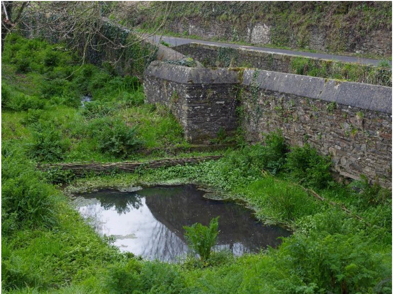
Lavoir séparé de la fontaine par le mur de clôture du parc. Vue générale nord-est
