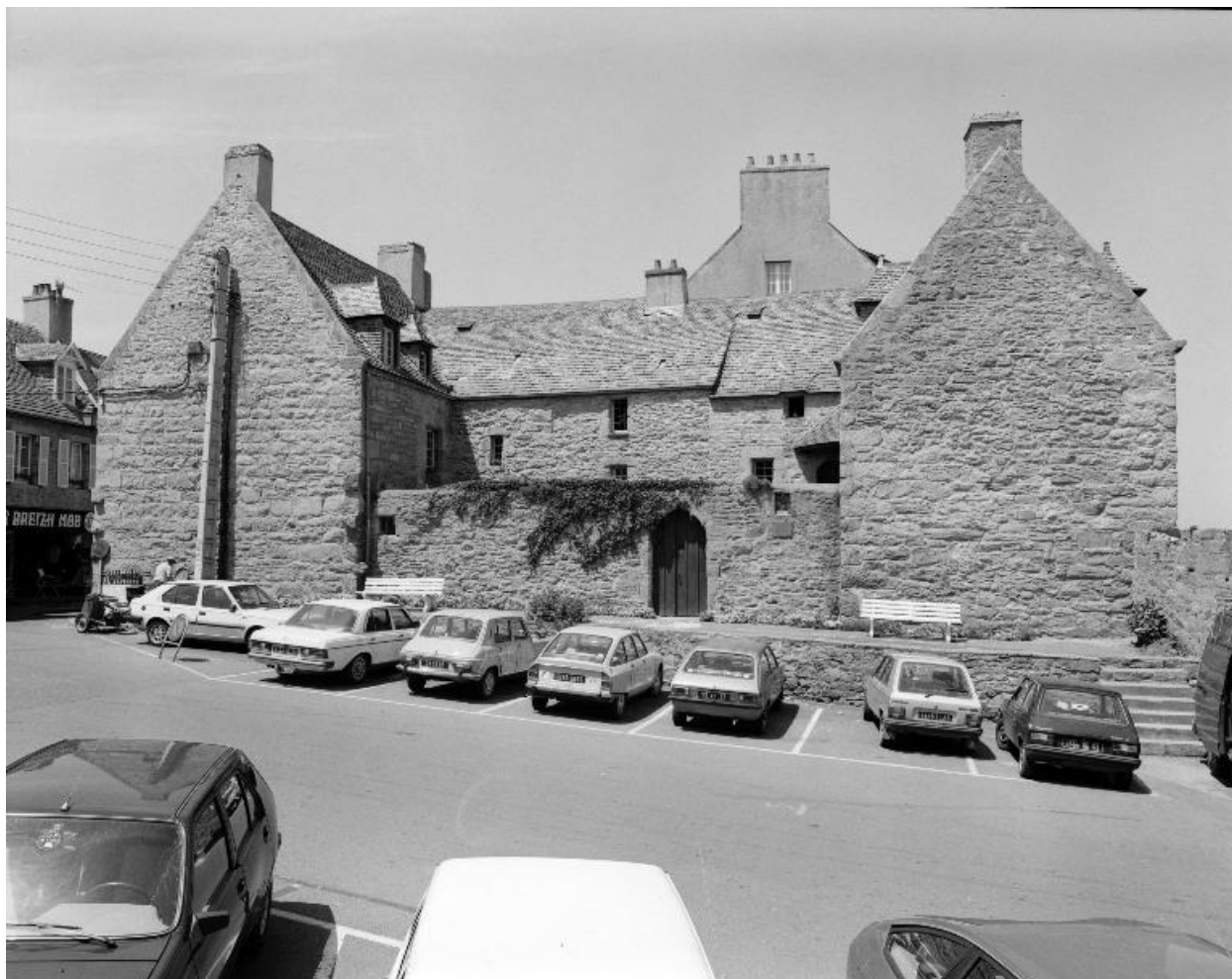
Elévation est, vue générale
