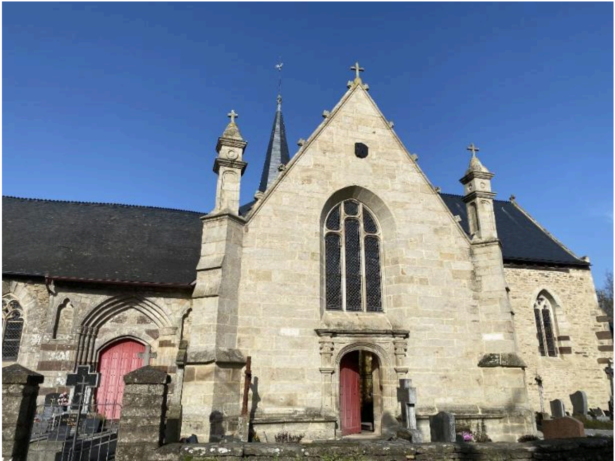
Élévation sud, détail
