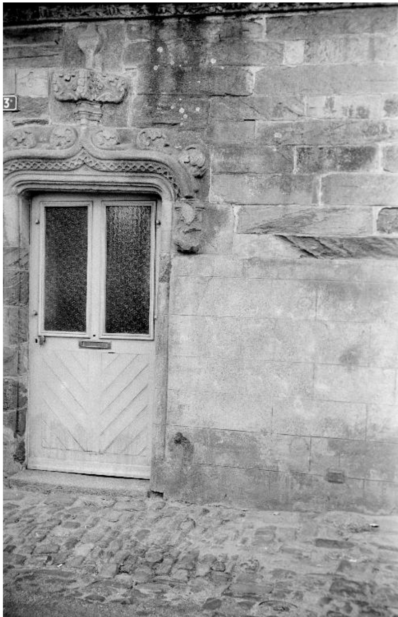
Maison : la porte (état en 1969)
