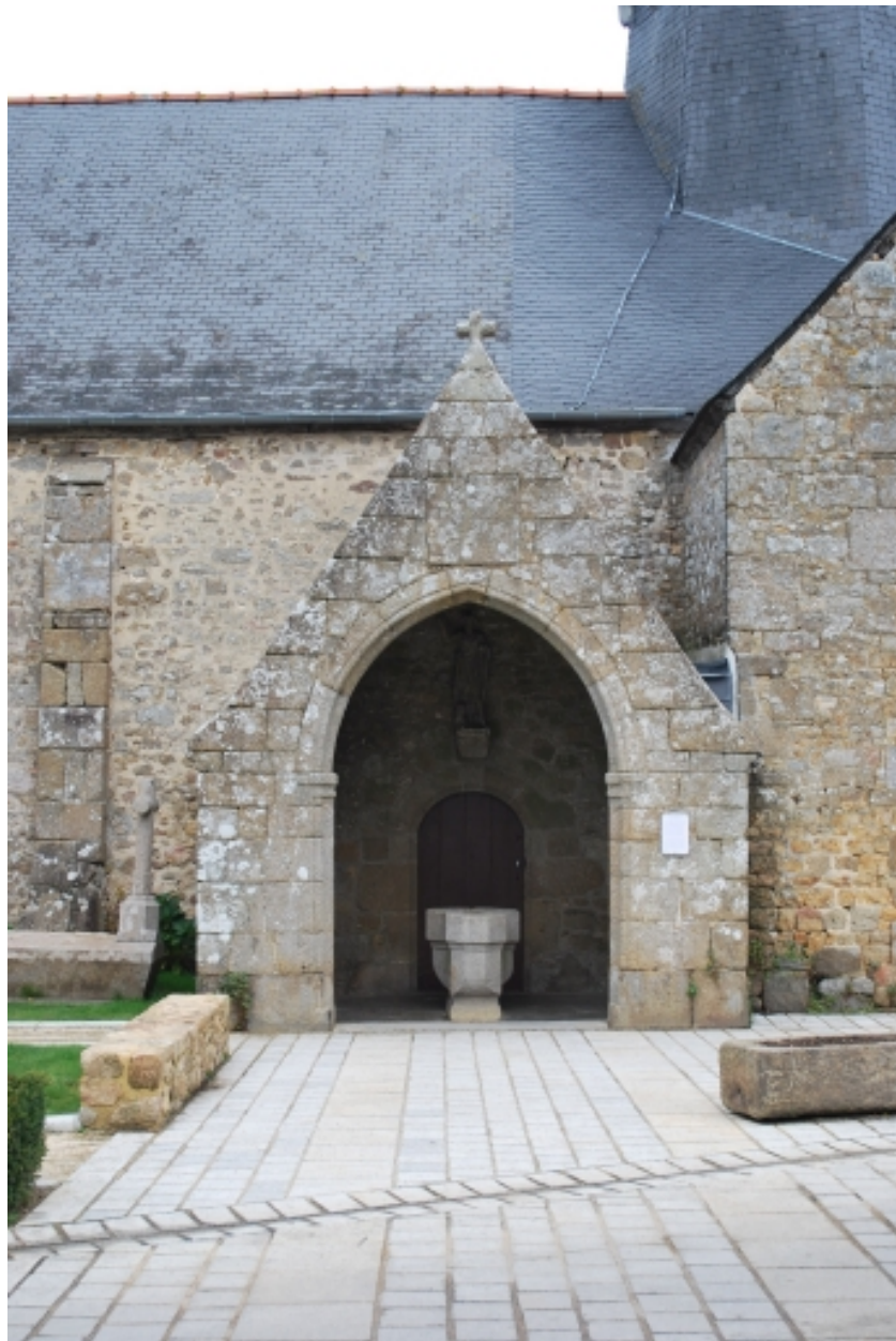
Elévation sud, partie centrale, fonts baptismaux : vue générale
