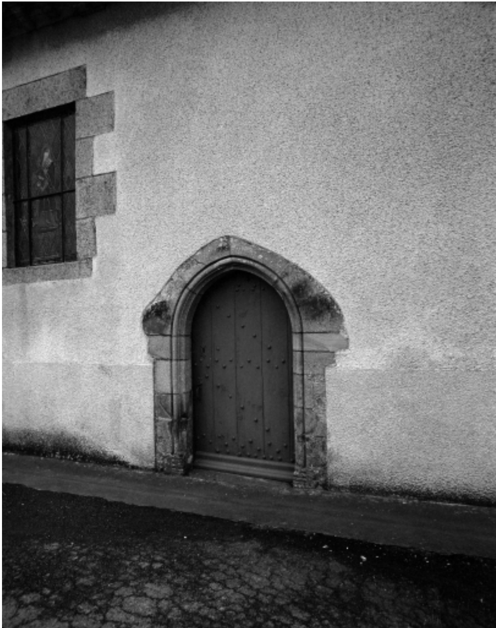
Elévation Nord, porte : vue générale
