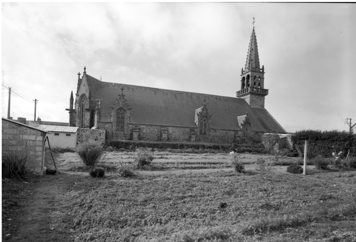
Vue générale de la façade nord
