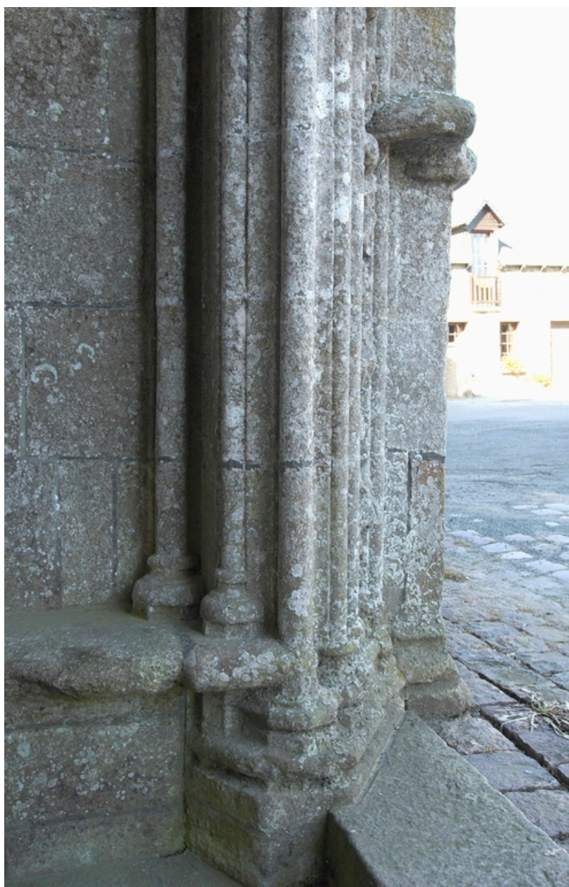
Porche nord ébrasement droit de l'arc d'entrée.
