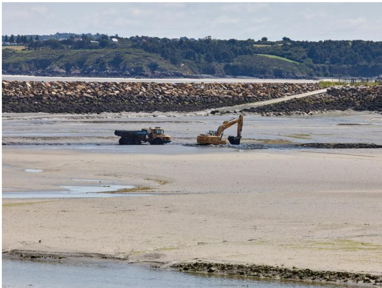
Intervention de dragage sur le chenal
