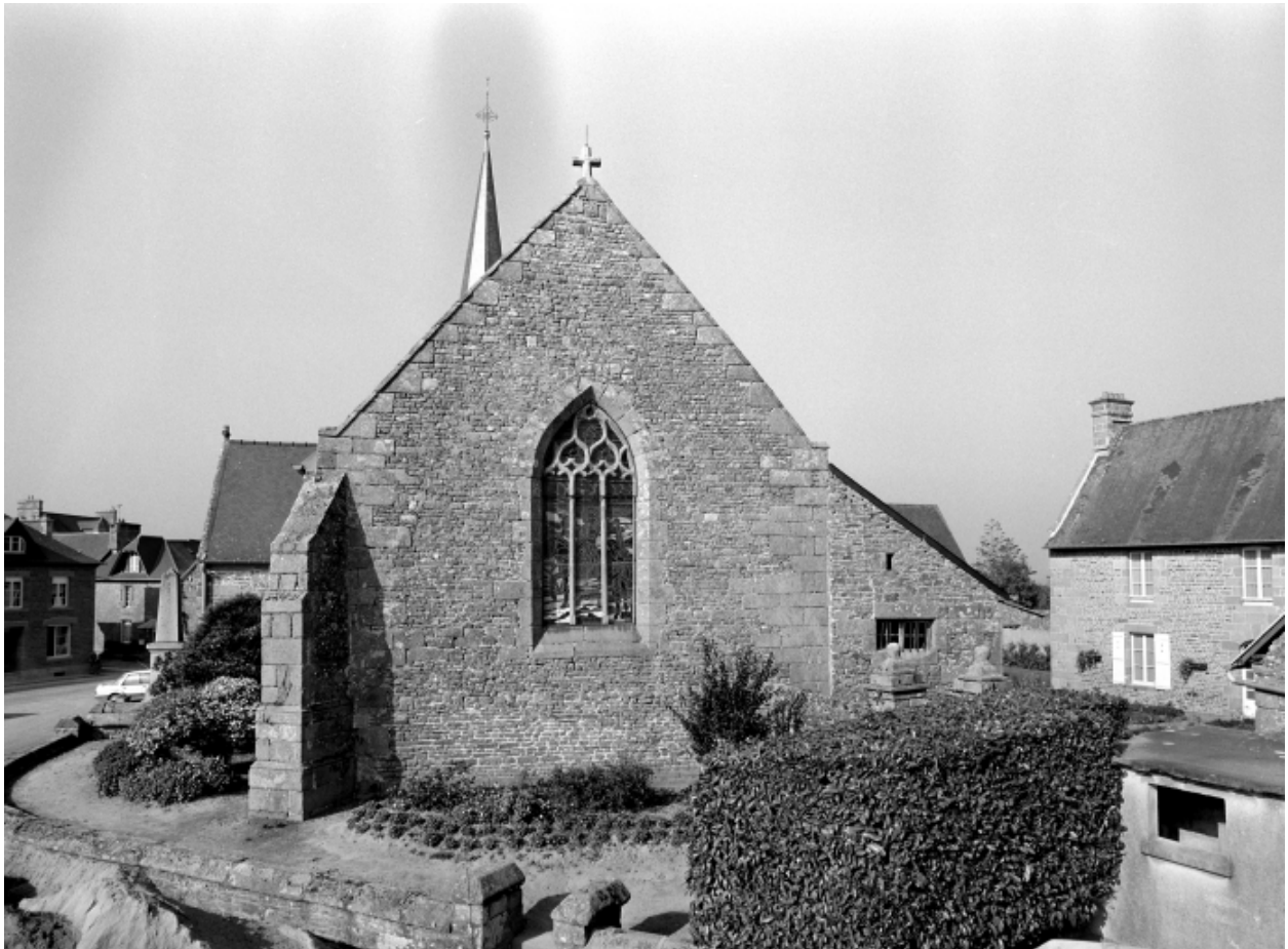
Elévation Sud-Est : vue générale
