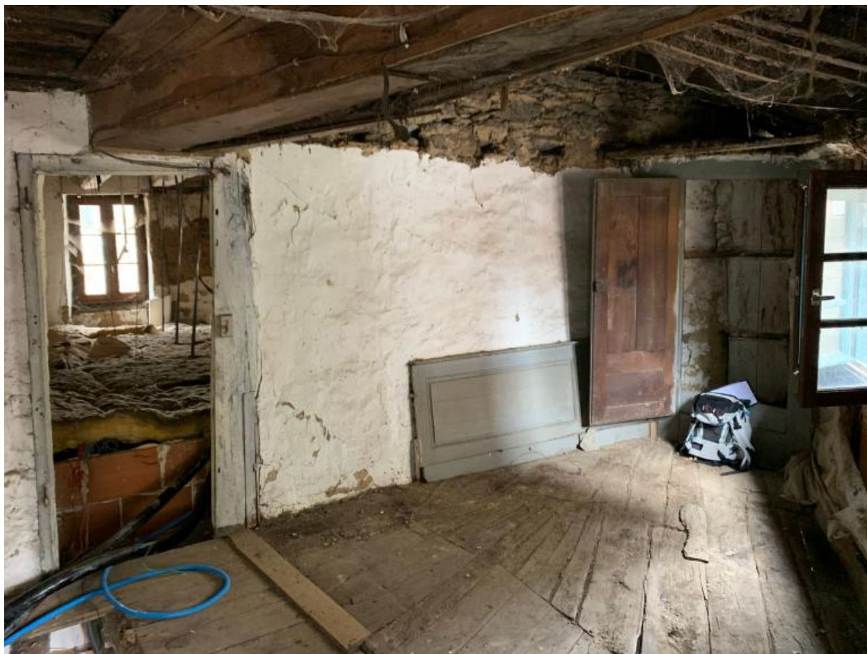
Intérieur, premier étage, pièce ouest
