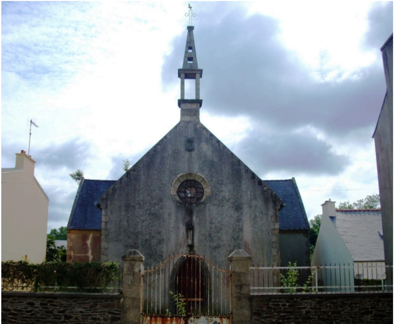
Chapelle Sainte-Anne de Kerinou : élévation ouest
