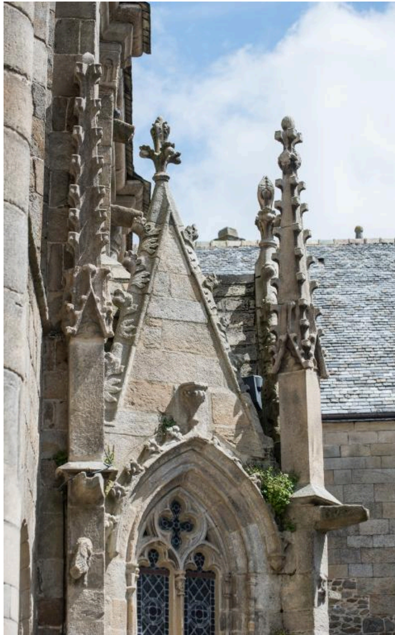
Mur sud de la nef : vue des pignons de la petite chapelle gothique
