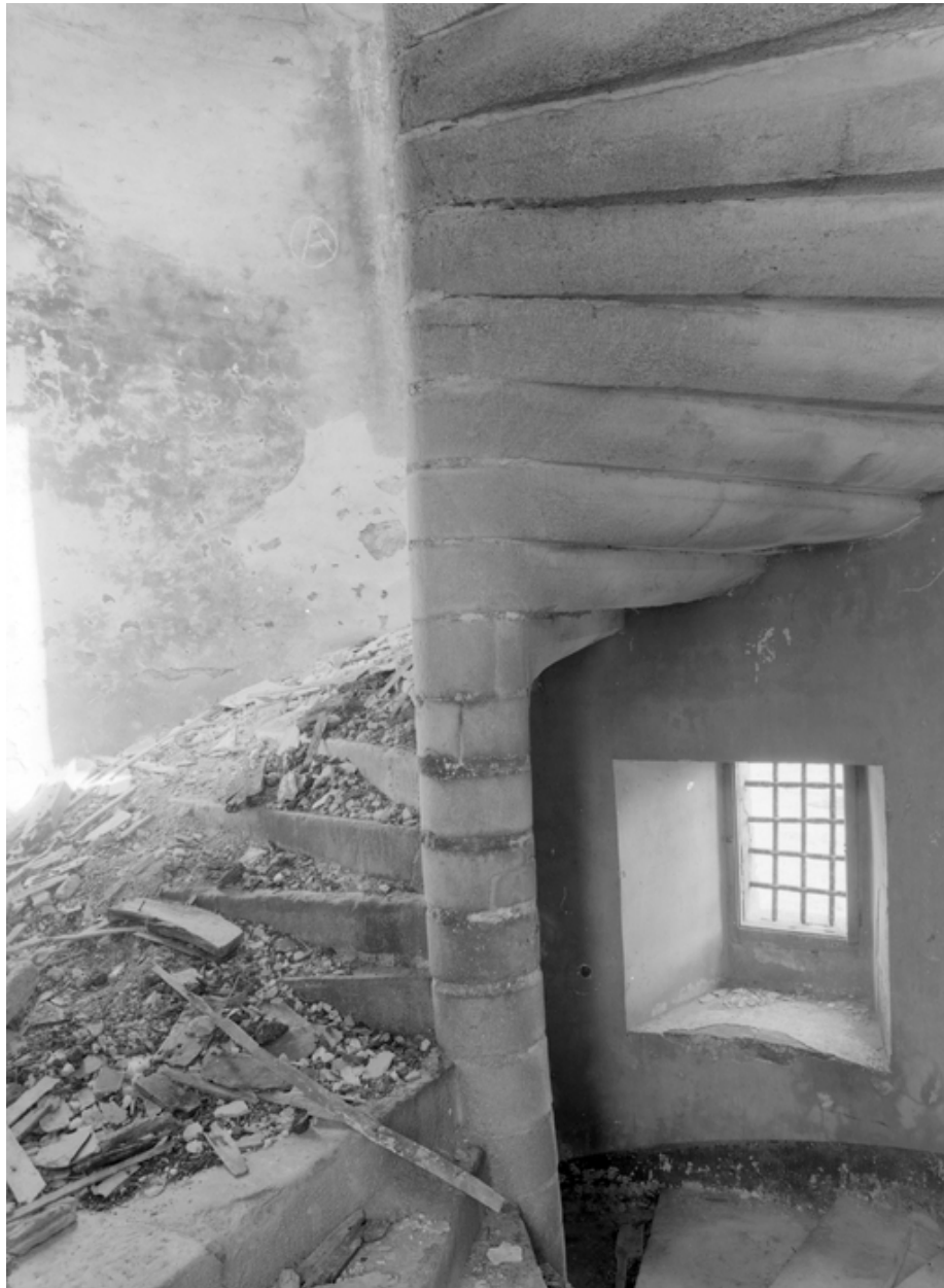
Etage, escalier : vue prise du palier.
