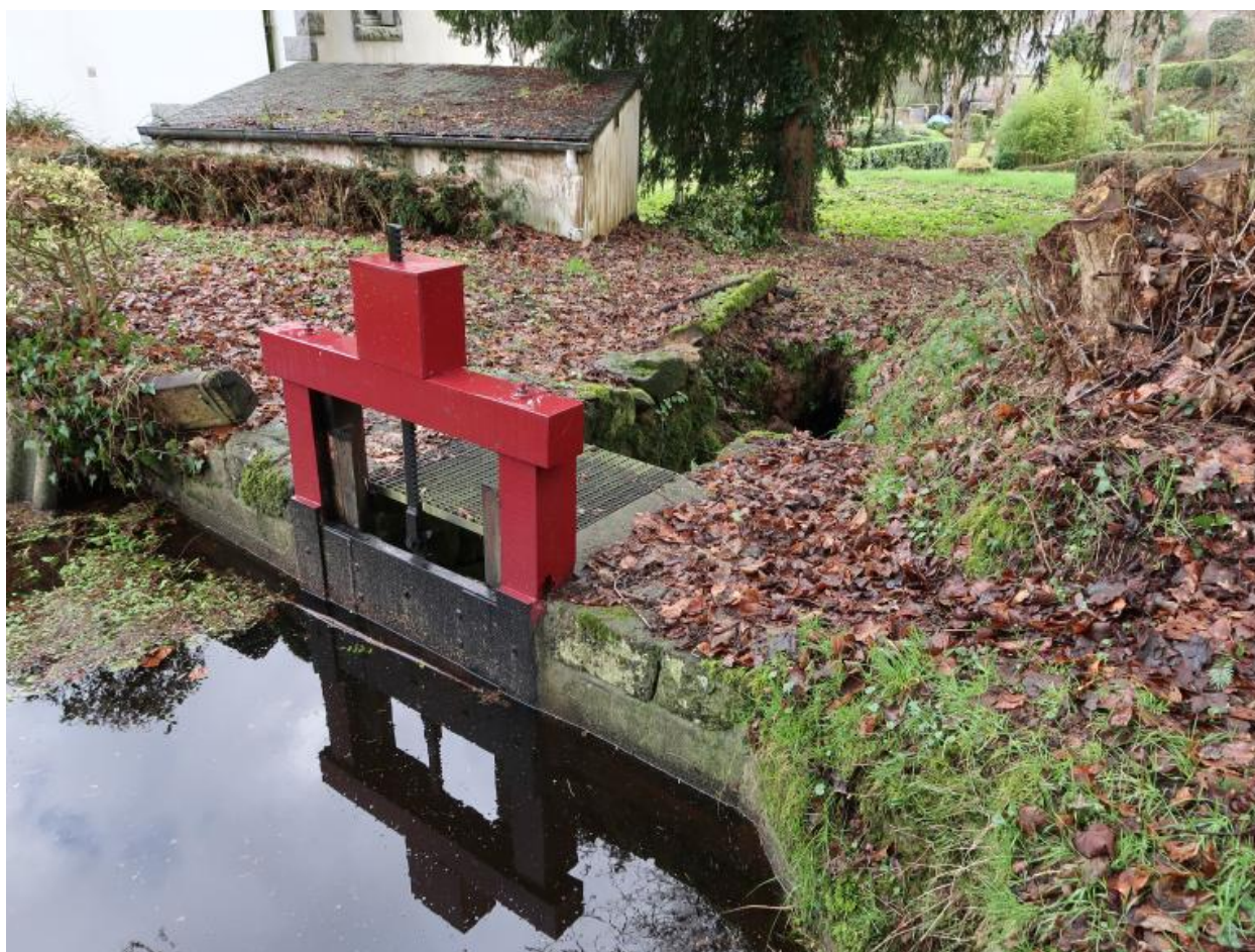
Loguivy-Plougras, le bourg : Moulin à eau de Traou an Dour, entrée de la rigole du canal d'aménée (vanne permettant de réguler ou fermer l'alimentation en eau depuis l'étang)
