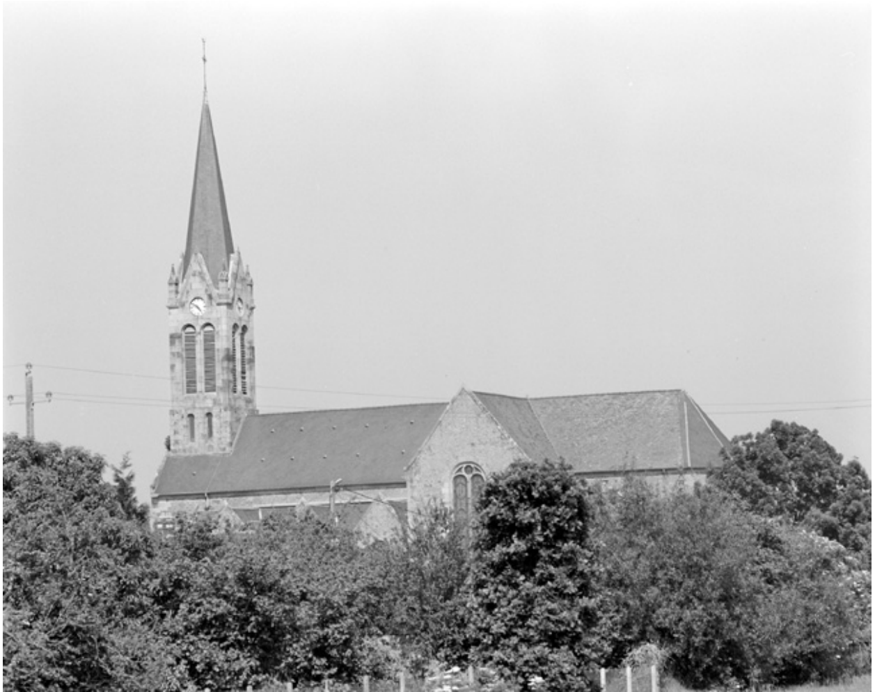
Élévation Sud : vue de situation
