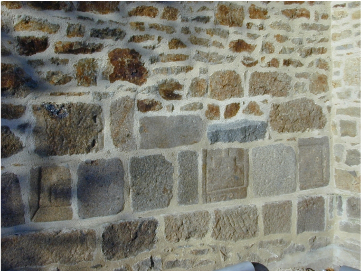
Sacristie, oriental monté avec des pierres de remplis : vue partielle sud-est
