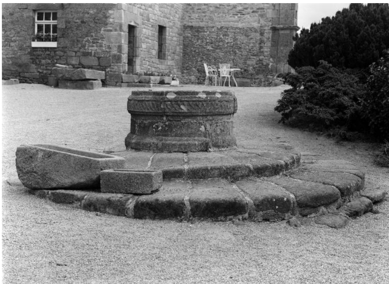
Puits, vue générale
