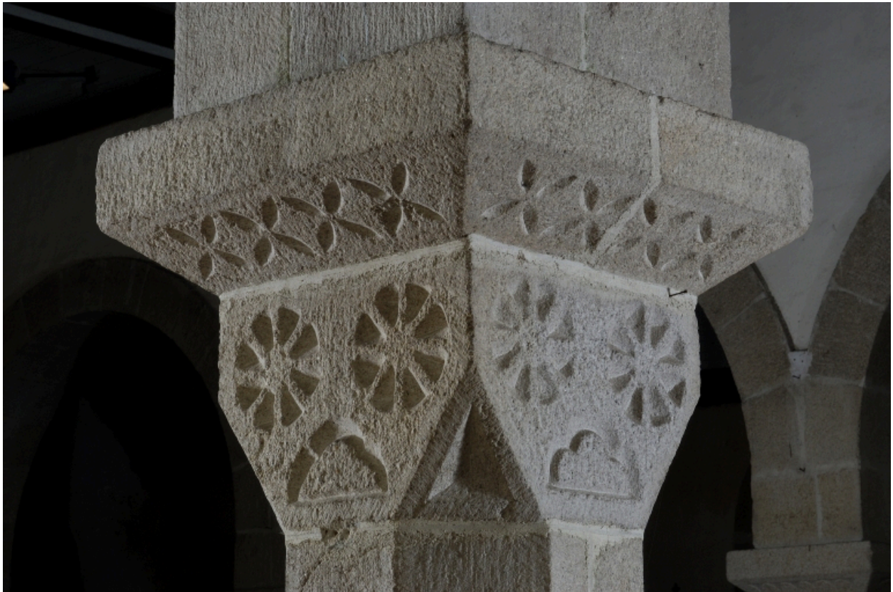
Locunolé, église paroissiale Saint-Guénoé : nef, chapiteau 2, état en 2004
