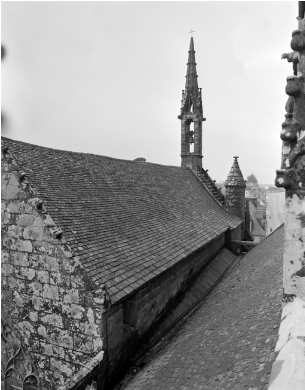
Chapelle du Pénit, toiture, versant nord
