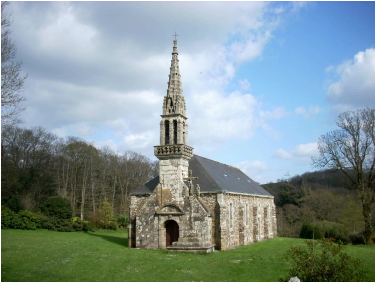
Dinéault, chapelle Saint-Dispar : vue générale sud-ouest
