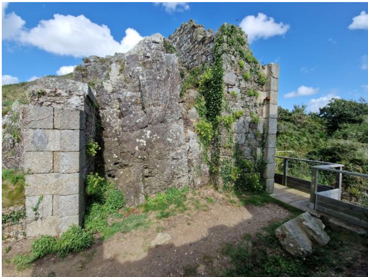
Vue de la porte basse avec son nouvel accès (état en 2024)
