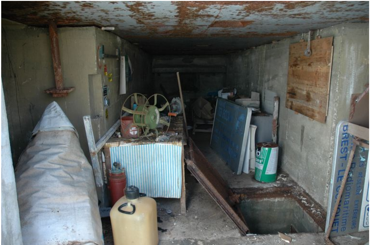
Vue de l'ensemble fortifié de la pointe du Renard : abri de type 601 pour canon antichars avec toit blindé, accès à la soute à munitions
