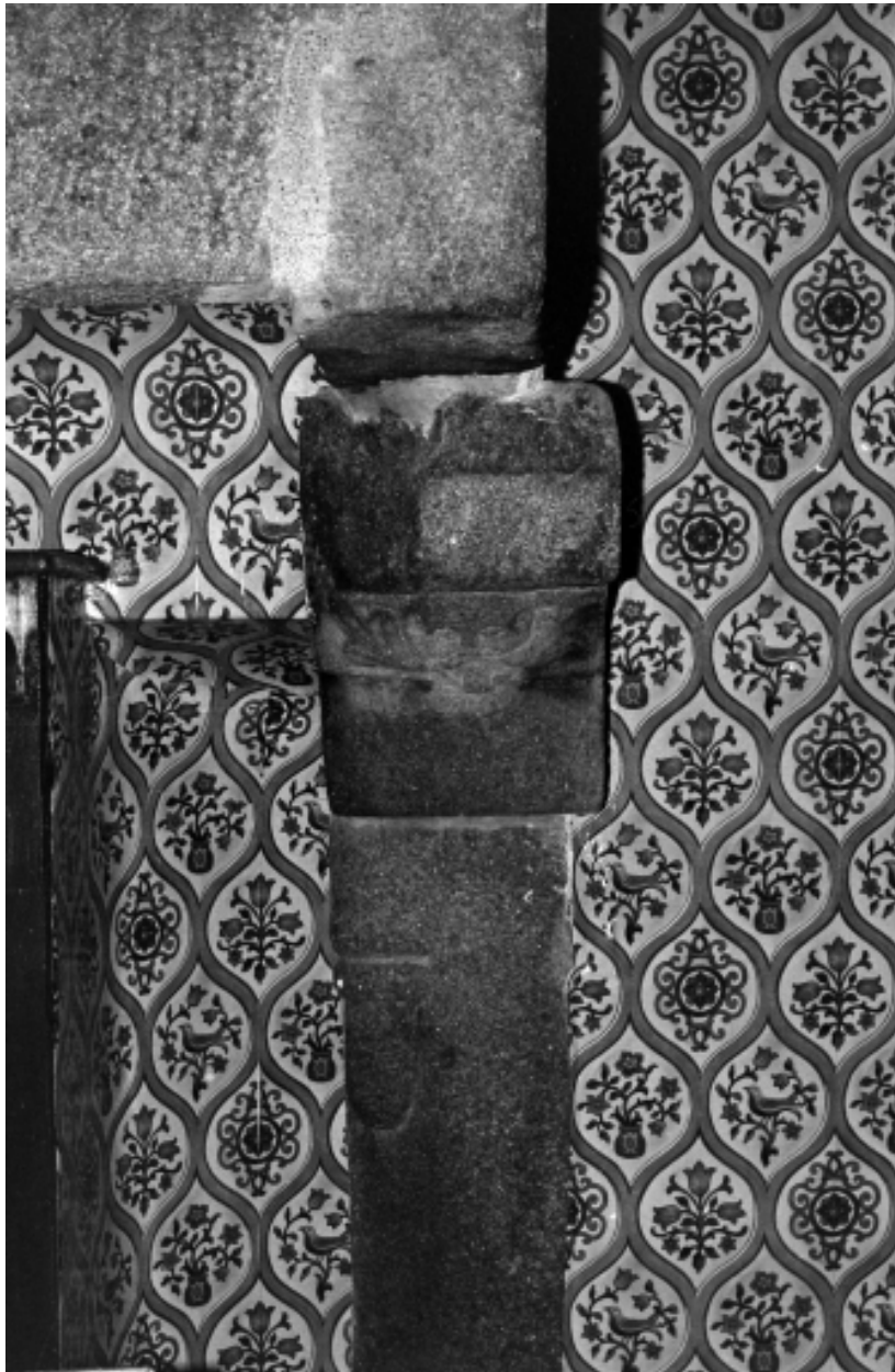
Cheminée du rez-de-chaussée : piédroit
