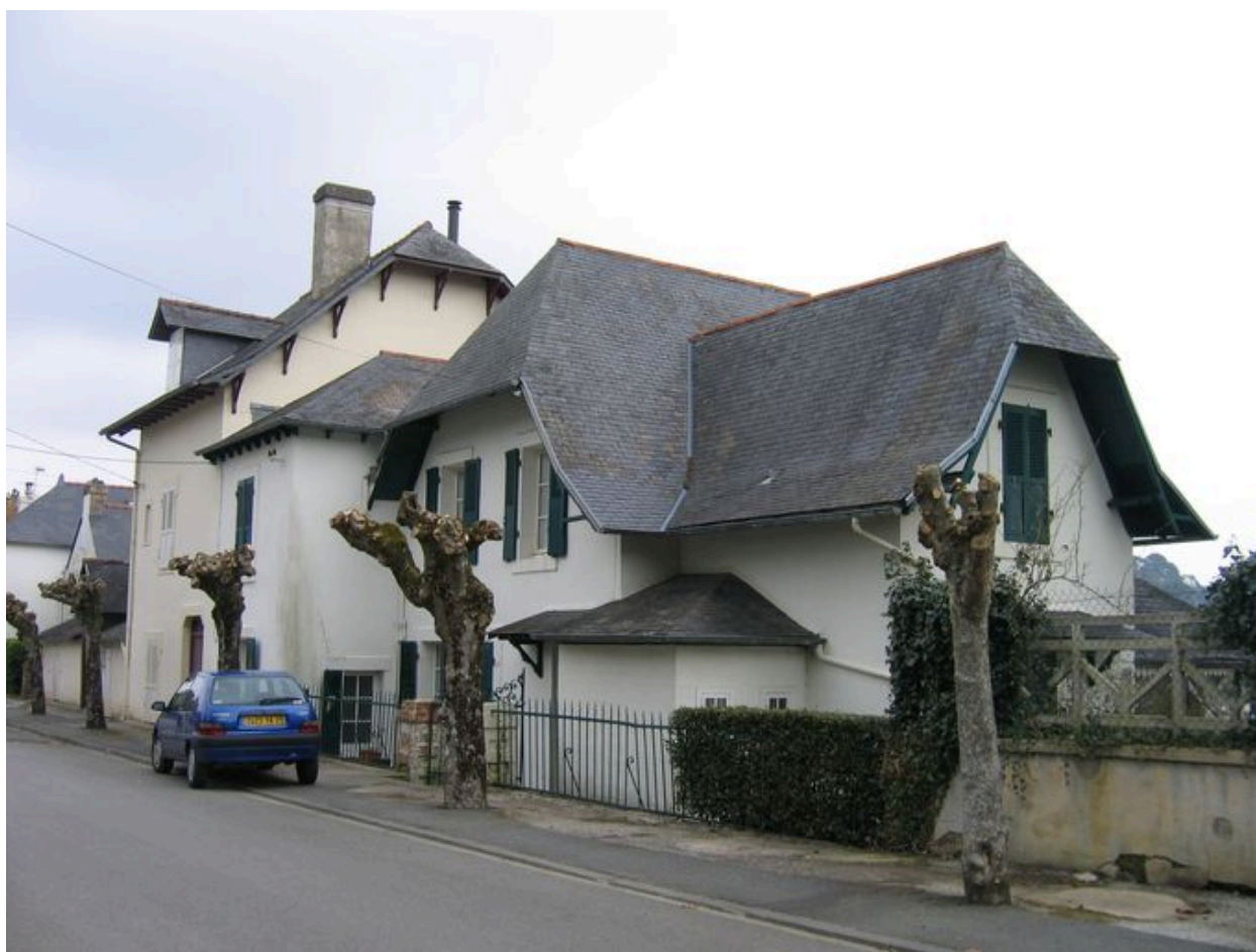
Vue arrière de la villa Kador, côté terre
