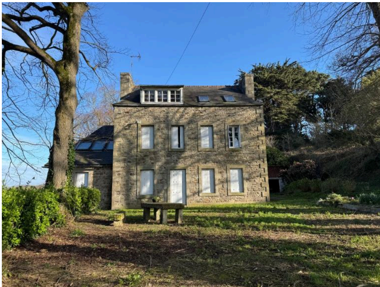
Maison patronale. Vue générale sud
