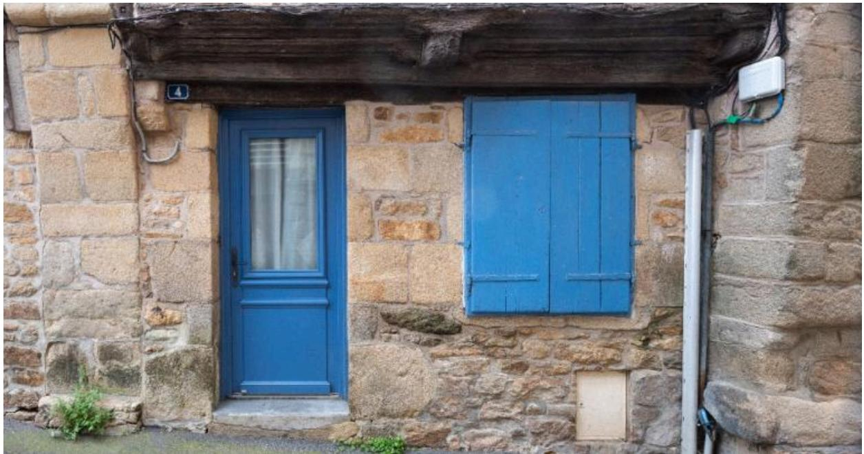
Le rez-de-chaussée, repris en sous-œuvre, est désormais maçonné.
