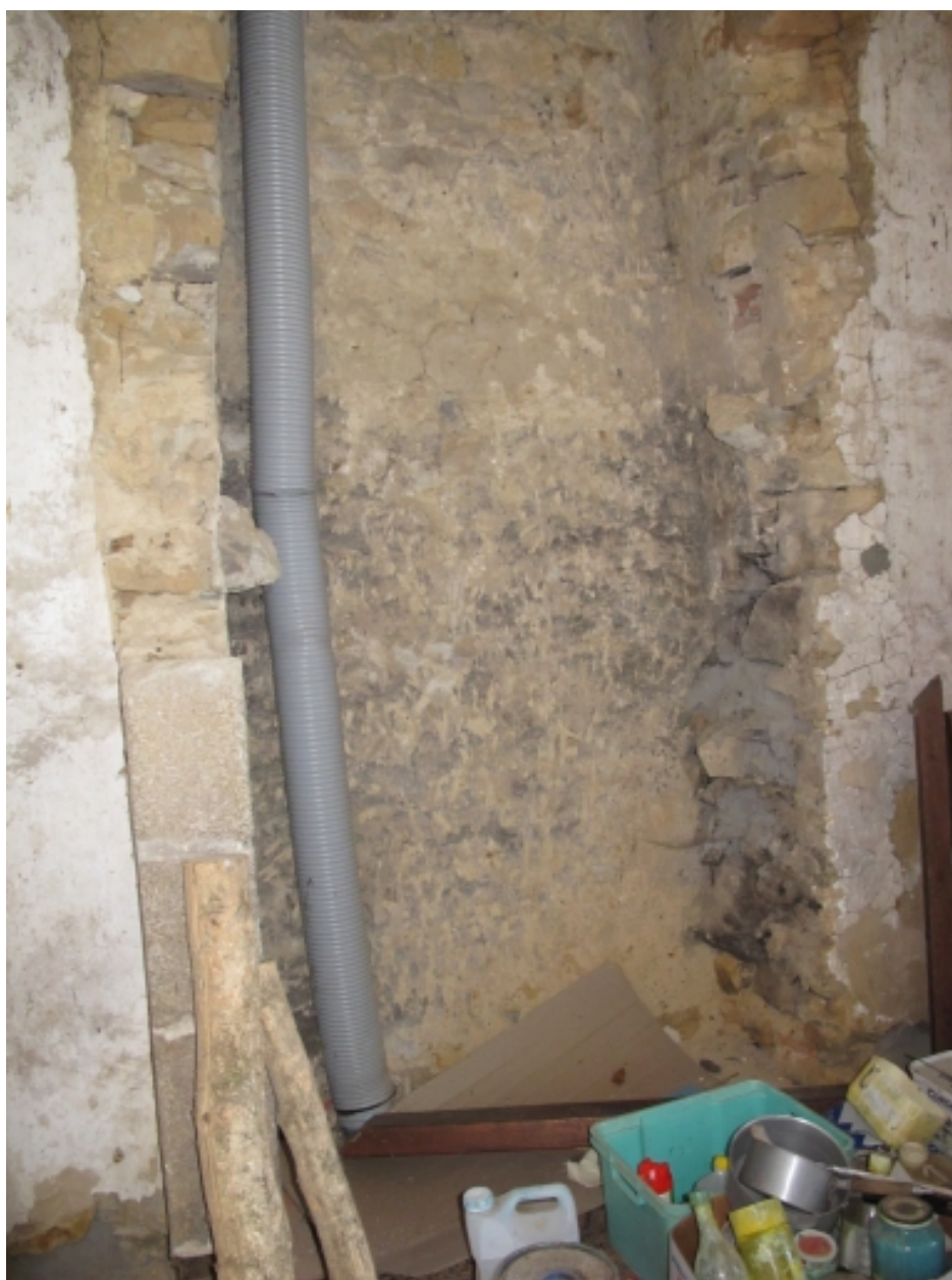
Vestiges d'une cheminée située dans un cabinet de l'étage (façade nord)
