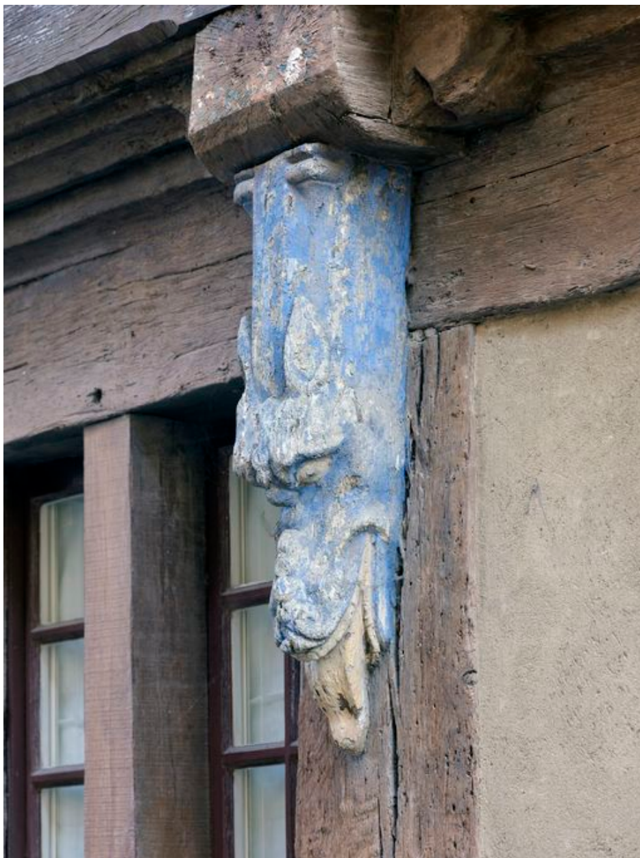
Elévation sud, rez-de-chaussée, décor du poteau d'huisserie : tête de dragon (état en 2012)
