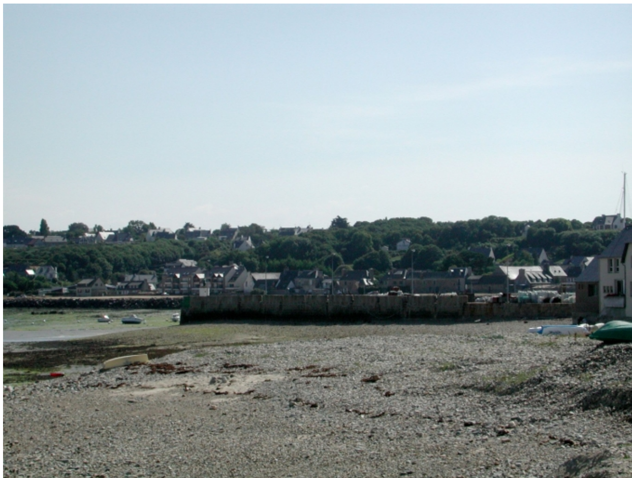
Vue de la face nord de la digue du Linkin
