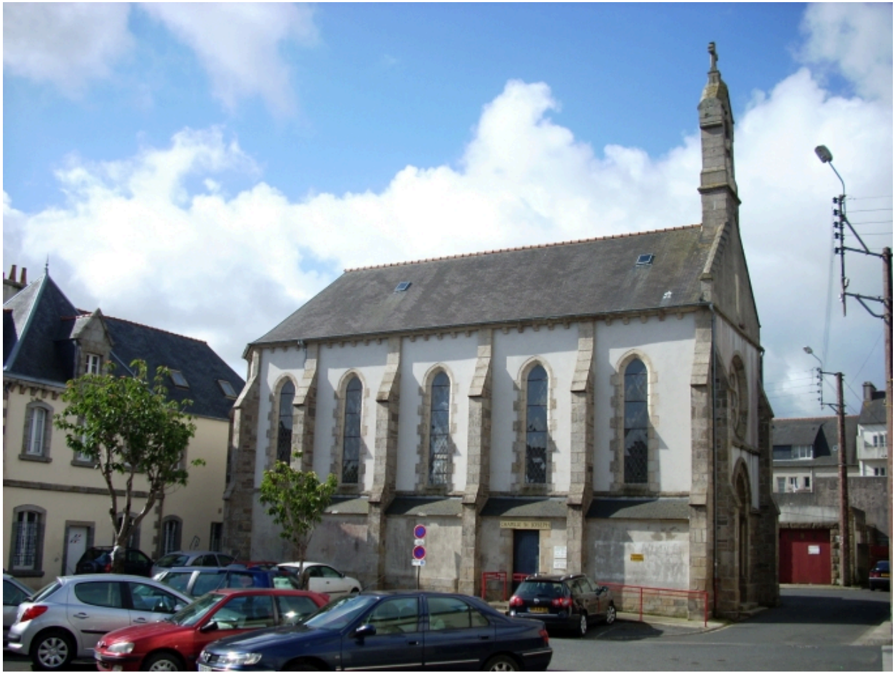
Lesneven, chapelle Saint-Joseph : vue générale nord-ouest
