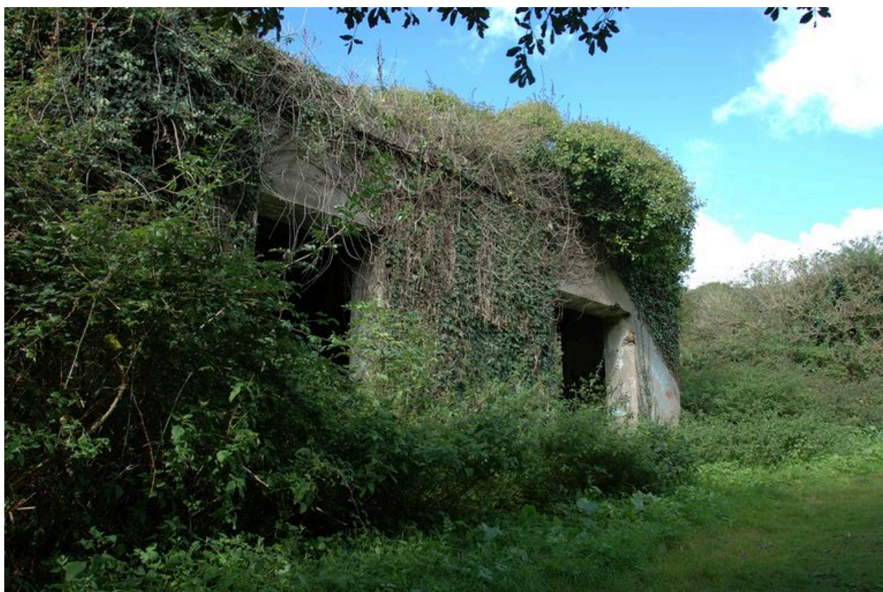
Vue de l'usine électrique (état en 2007)
