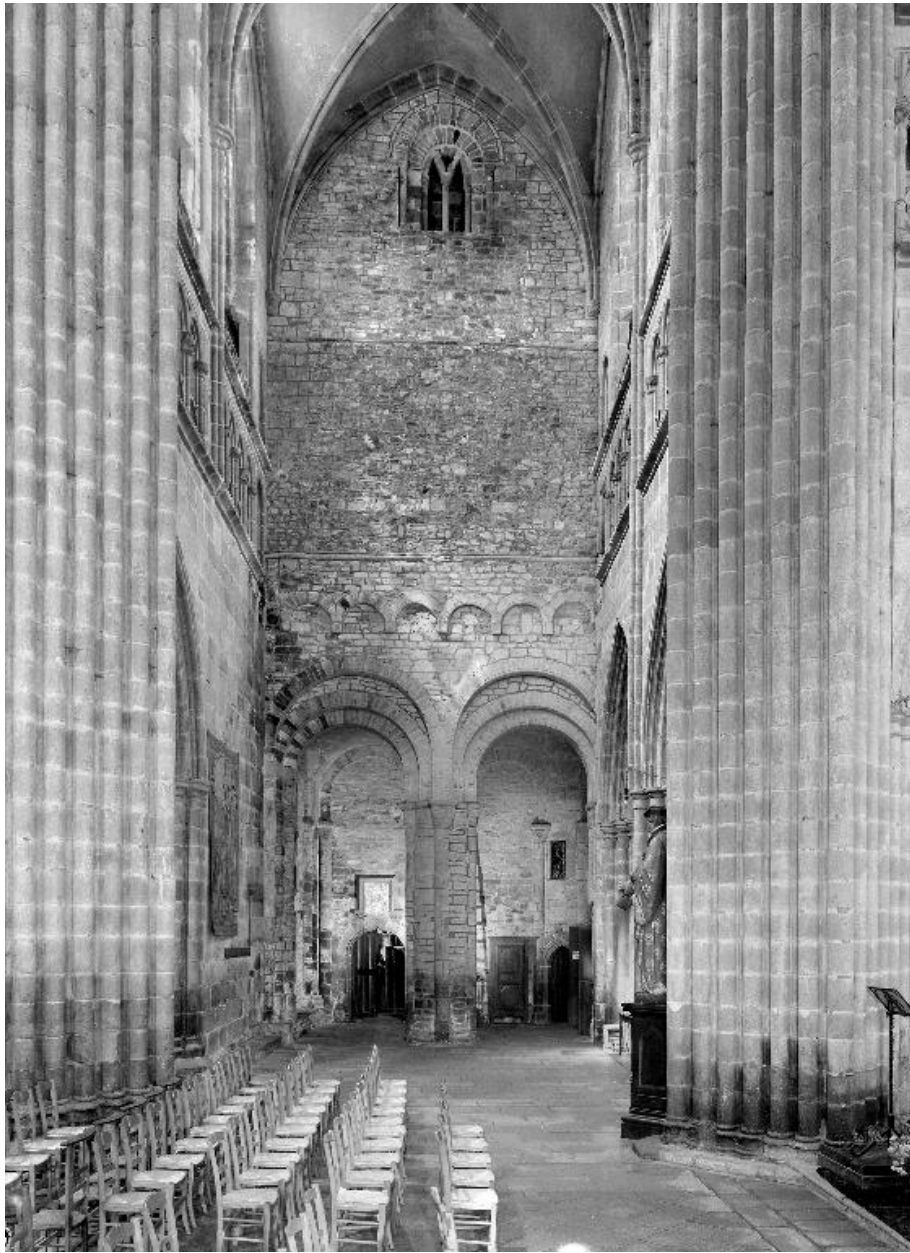
Elévation sud de la tour Hasting, vers le croisillon
