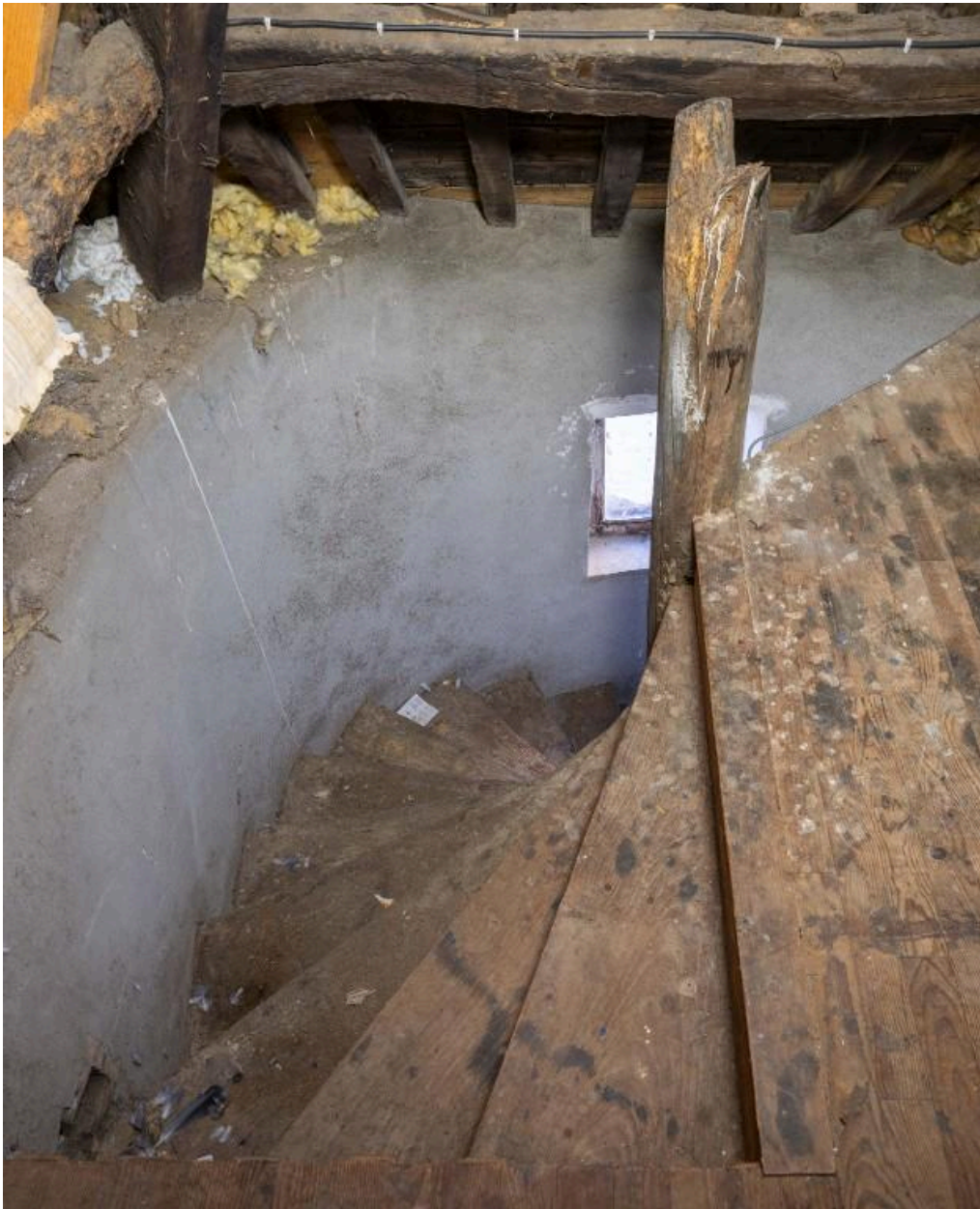
Partie haute de l'escalier en vis, au niveau du grenier actuel.
