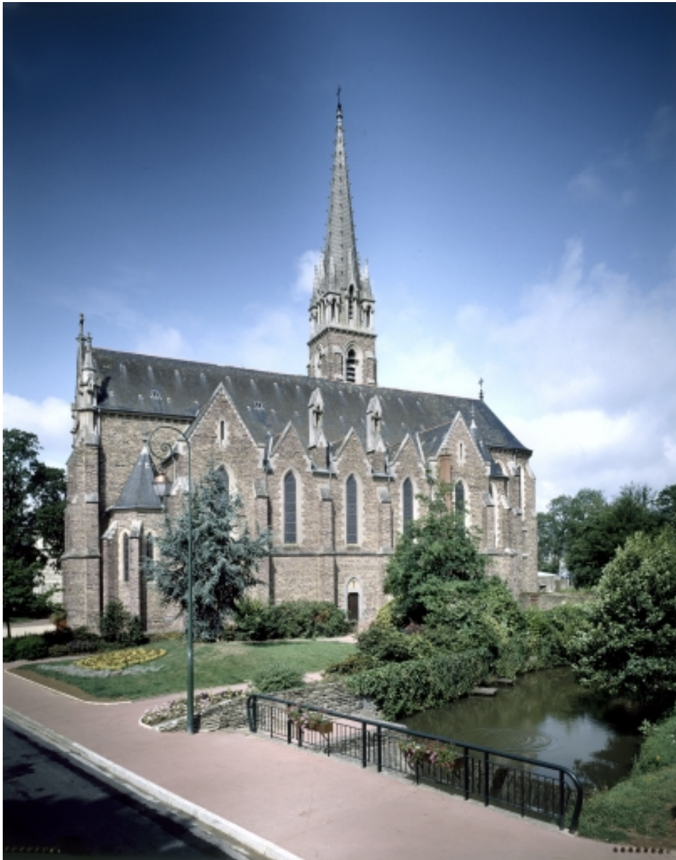
Vue d'ensemble de la façade latérale
