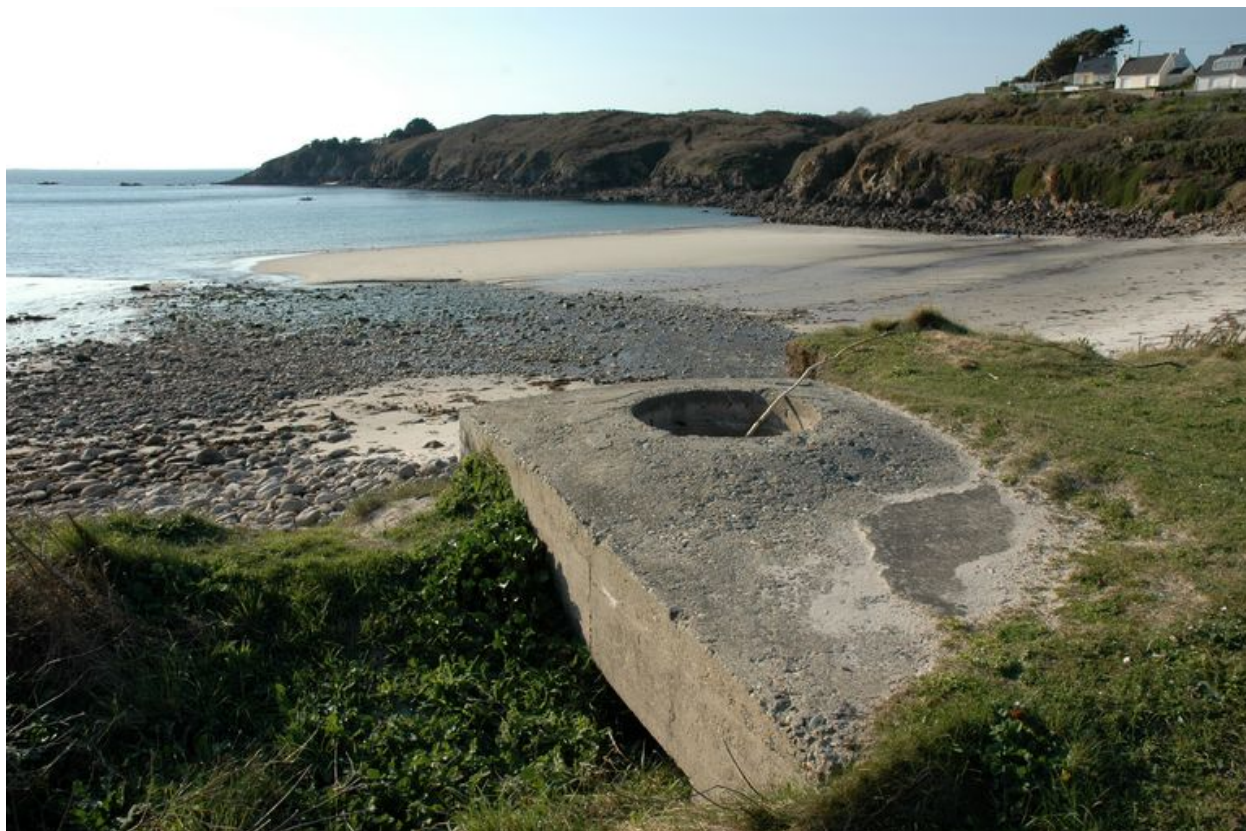
Vue d'un poste d'observation et de tir dit Tobruk-Stand au sud de la plage d'Illien (état en 2006)
