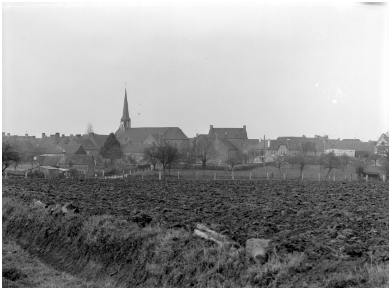
Elévation Sud-Est : vue de situation
