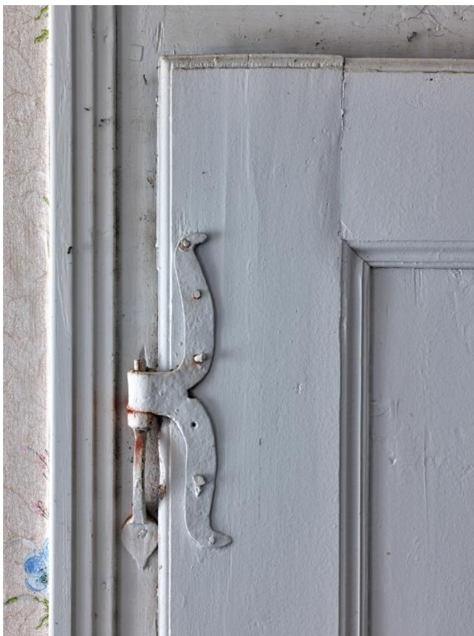
Logis 1831. Chambre à feu de l'étage. Porte. Détail de la charnière à penture moustache
