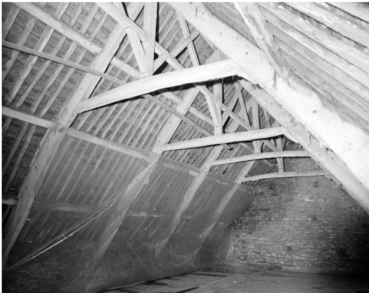
Charpente : vue générale.
