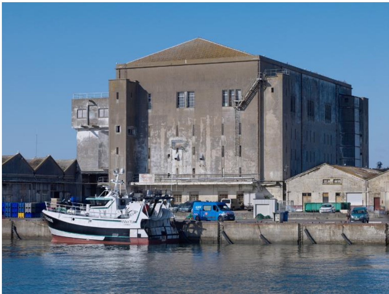
Frigorifique de Keroman, vue générale
