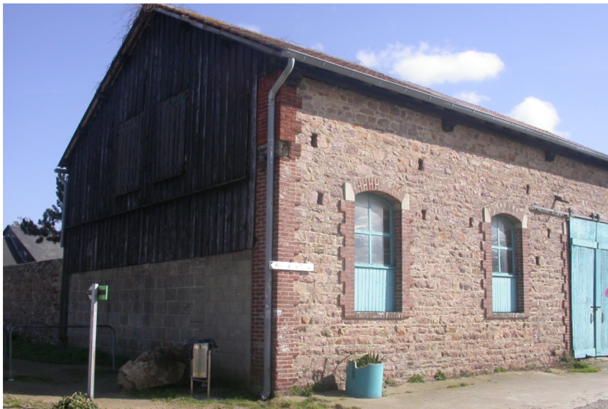
Partie ouest du bâtiment
