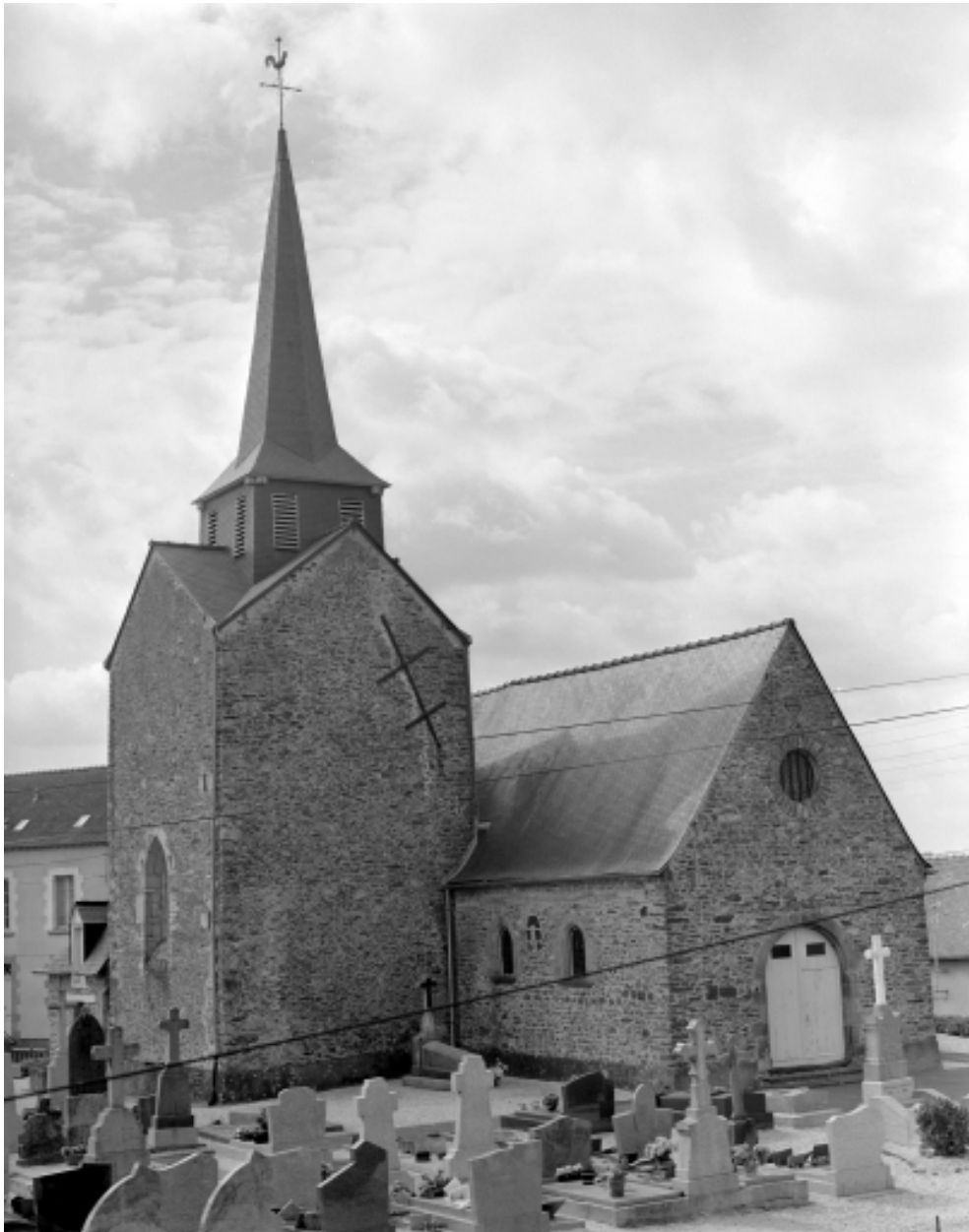
Elévation Nord-Ouest : vue générale
