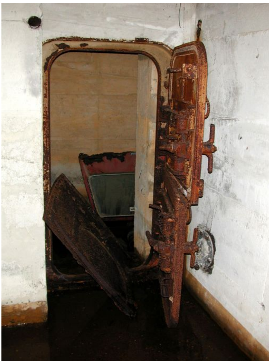
Vue intérieure : porte blindée (état en 2003)
