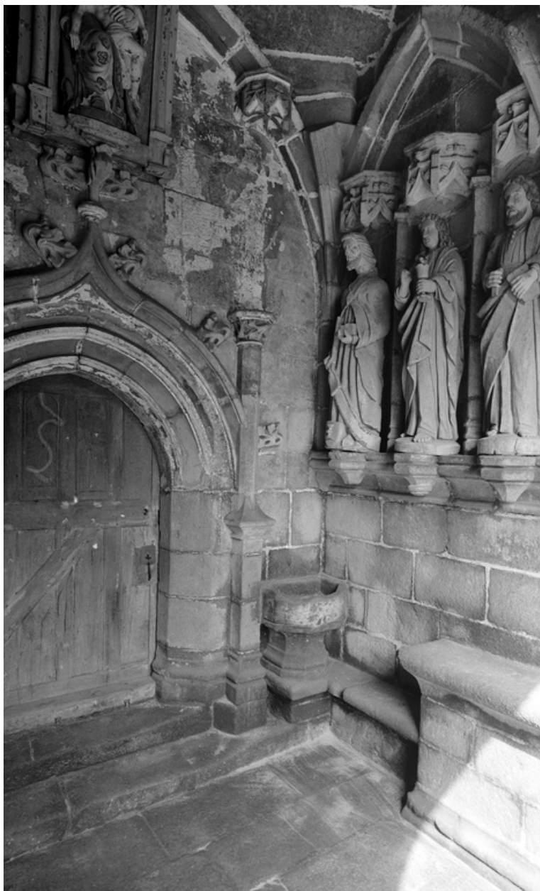
Porche sud, angle intérieur nord est : vue générale
