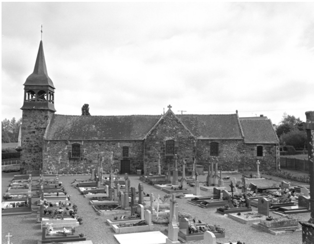
Vue générale sud
